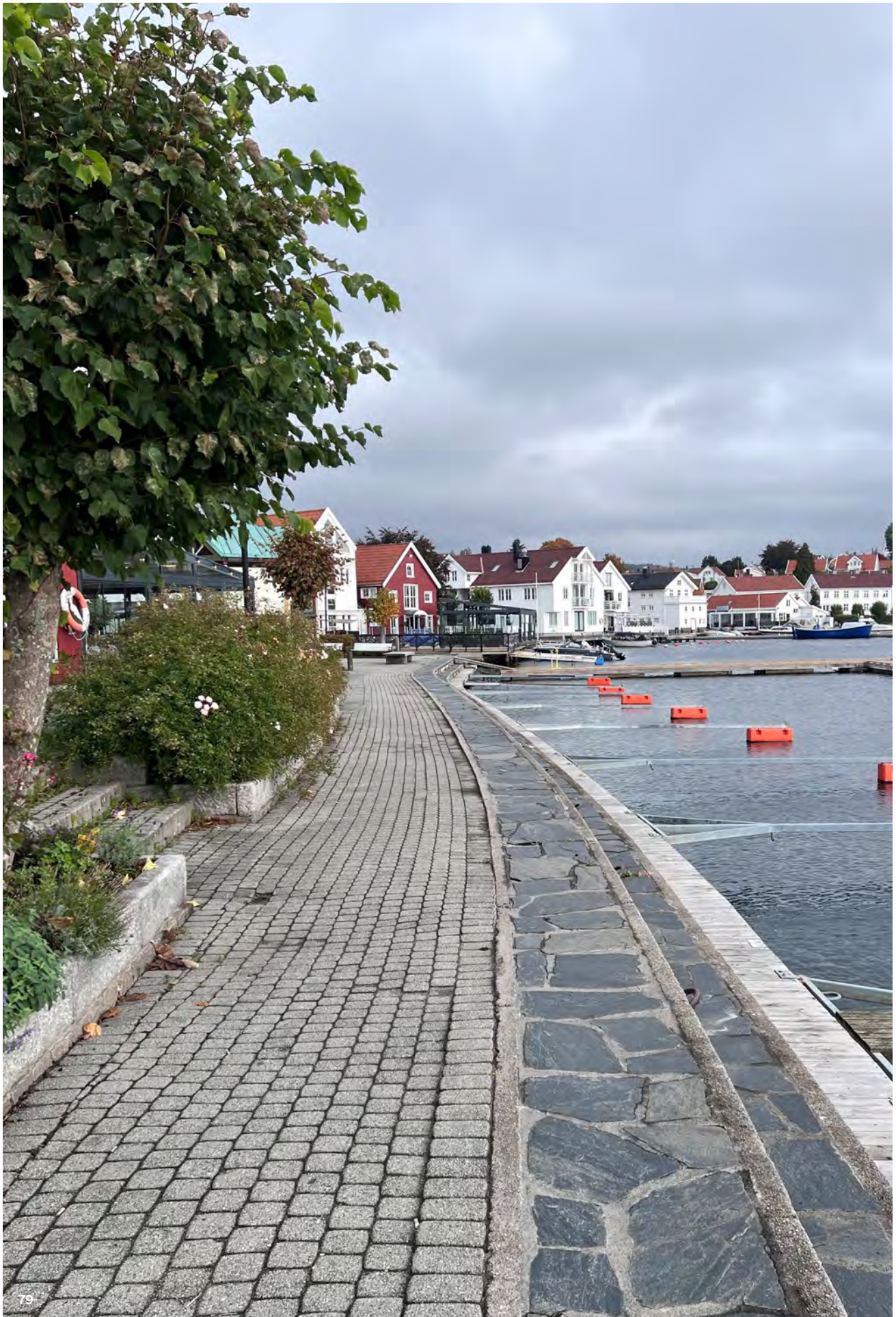
79. Eksisterende bryggekant i Lillesand sentrum. Nåværende betongstein erstattes med tredekke som vist på figur 78.
