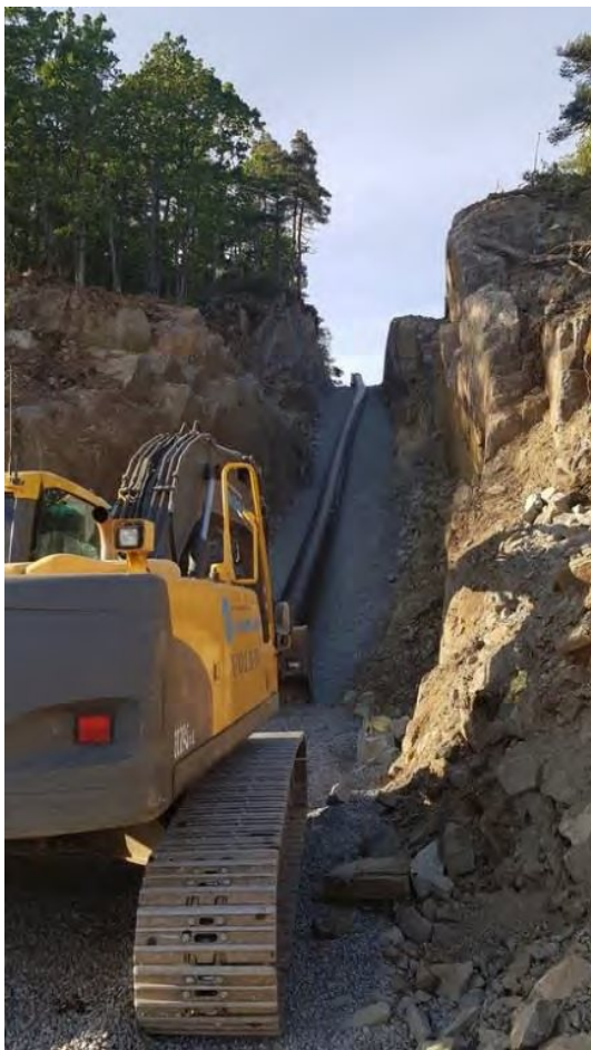
Figur 17 Vannledning 800 mm til nytt basseng på Grasåsen, del av reservevannledningen.
